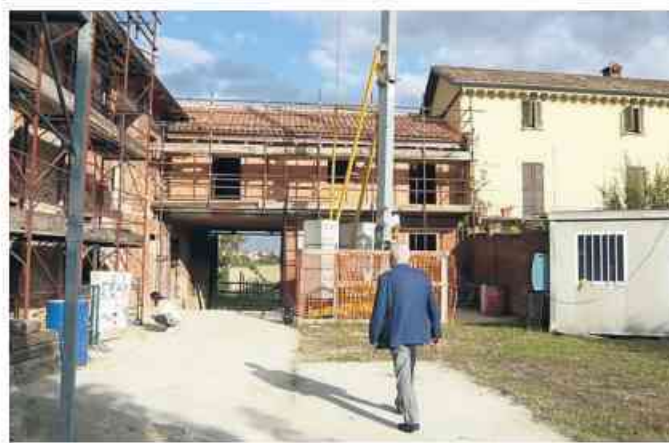
Il cantiere di Cascina Graziella a Moncalvo
